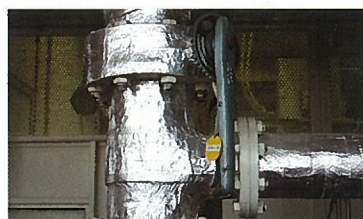
長野県須坂市 オリオン機械株式会社(乾燥炉ダクトの断熱)
