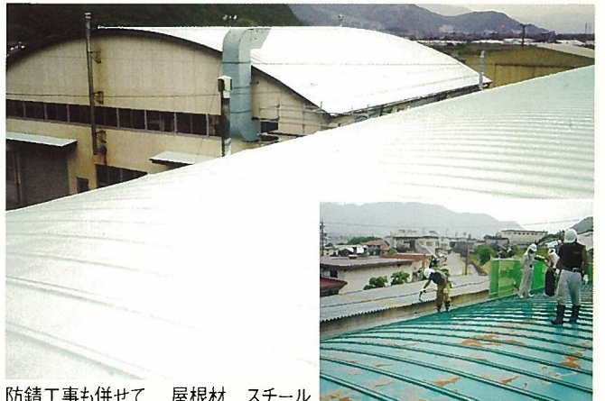
防錆工事も併せて 屋根材 スチール
